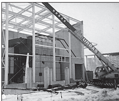
Рис. 5.6. Монтаж установки на биомассе.
