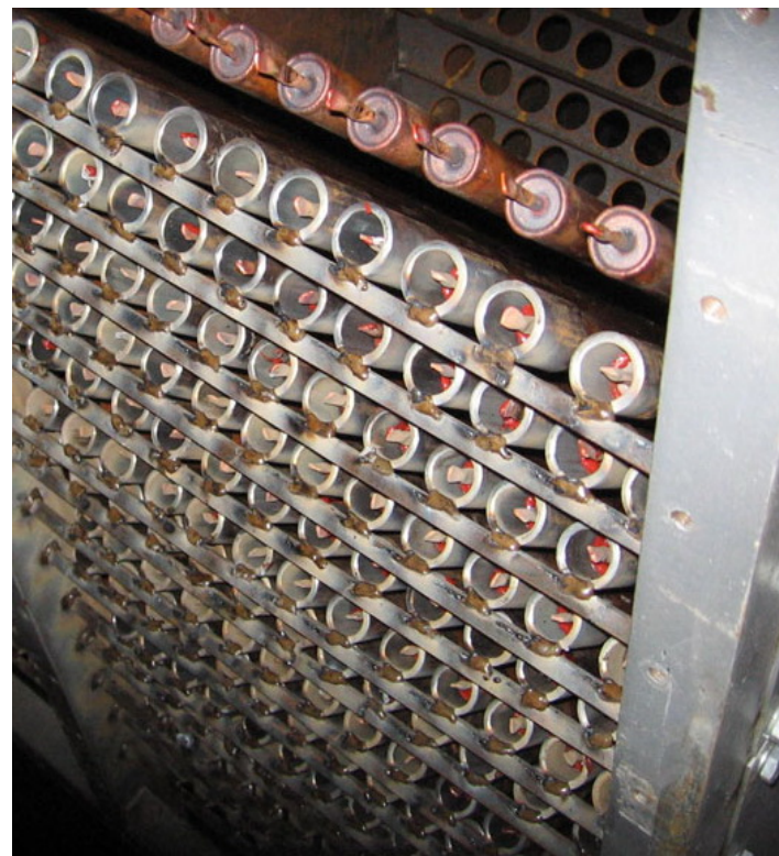
Теплообменник на тепловых трубах
