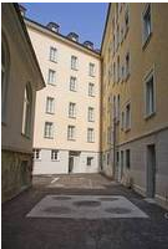
Рис. П.5. Вид крышки резервуара с теплообменником-утилизатором теплоты сточных вод
