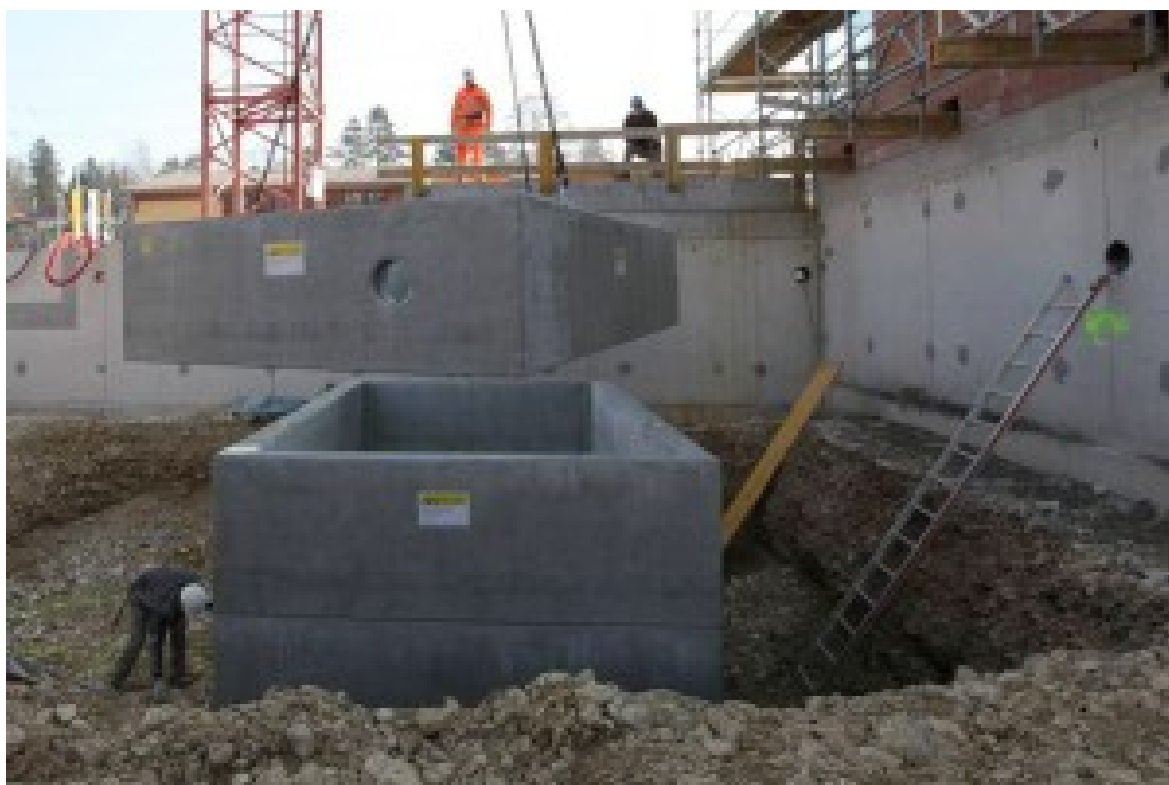
Рис. П.1. Сооружение резервуара сточных вод.
