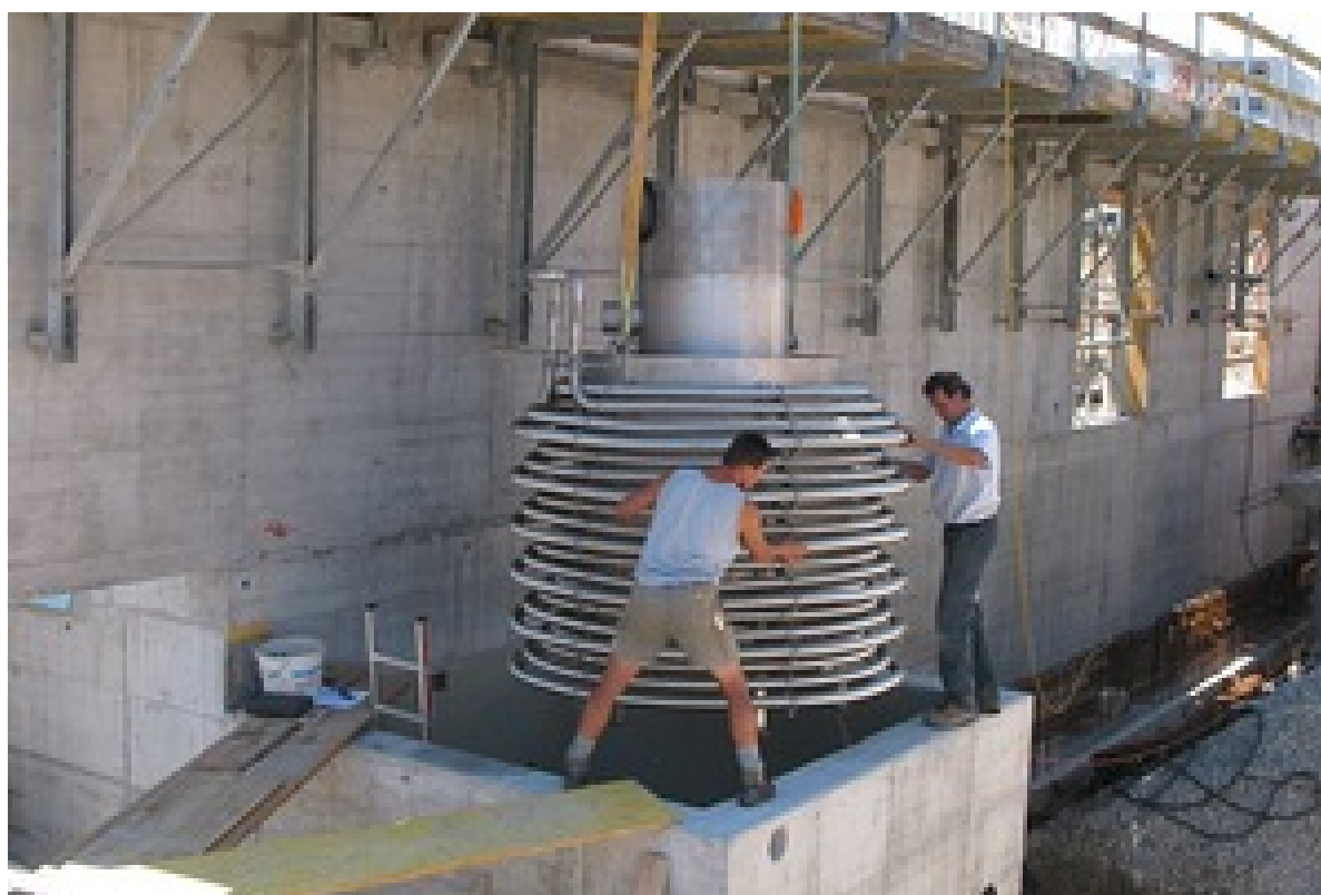
Рис. П.2. Монтаж погружного теплообменника-утилизатора теплоты сточных вод
