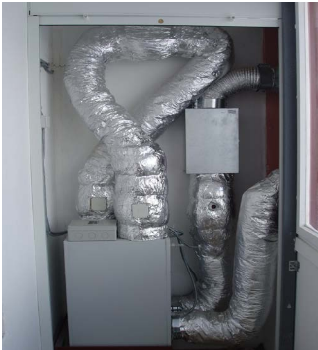
Рис. 3.5 – Программируемый блок управления системой вентиляции и системой отопления
