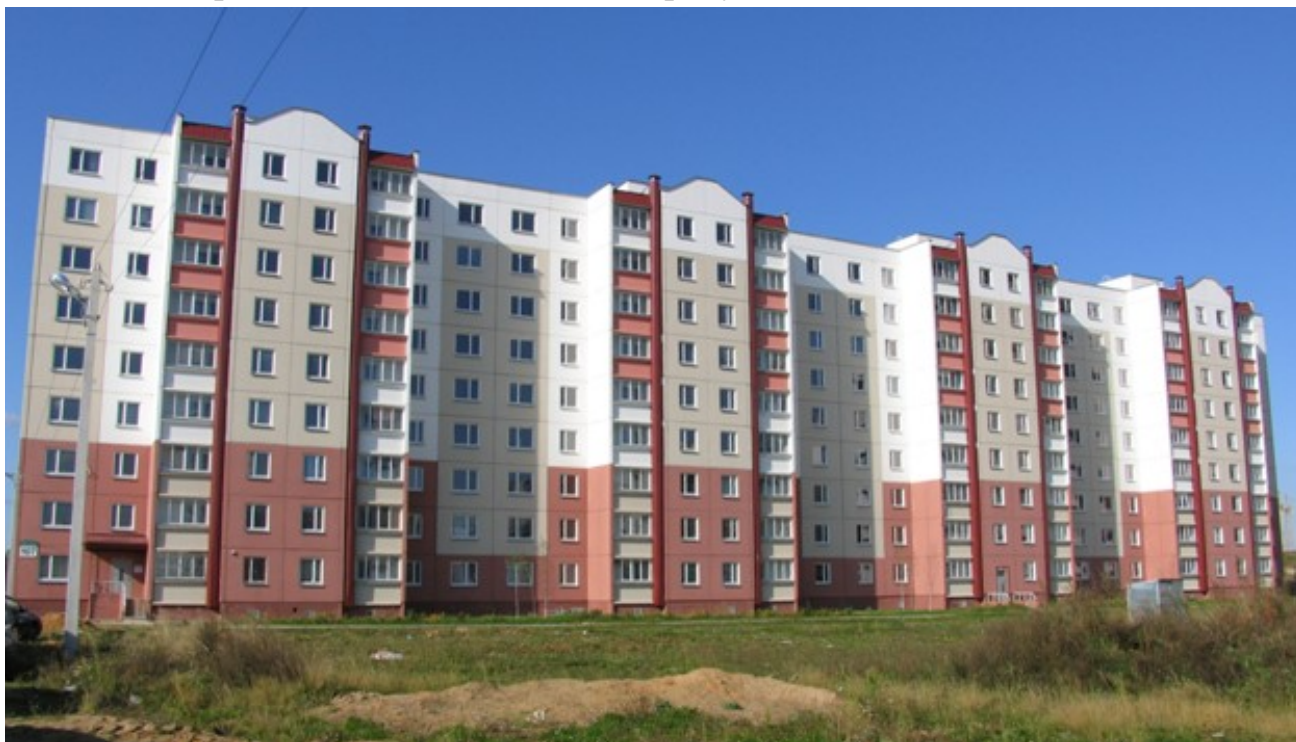
Рис. 3.1 – Энергоэффективный жилой дом в г. Минске
