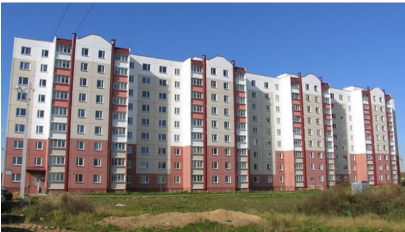
Рис. 6 – Энергоэффективный жилой дом в г. Минске
