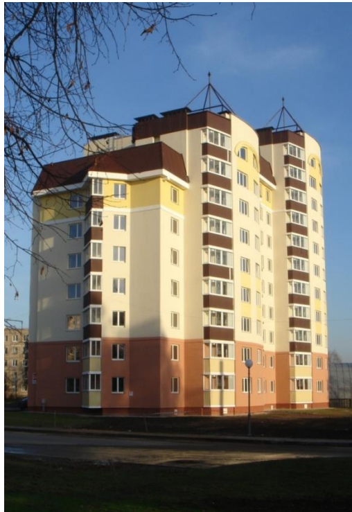
Энергоэффективное здание в г. Гродно
