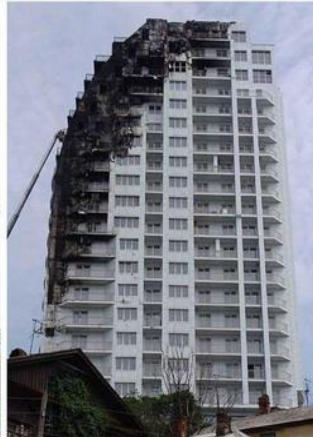
Пожар во Владивостоке - горит пенополистирол наружного утепления.
