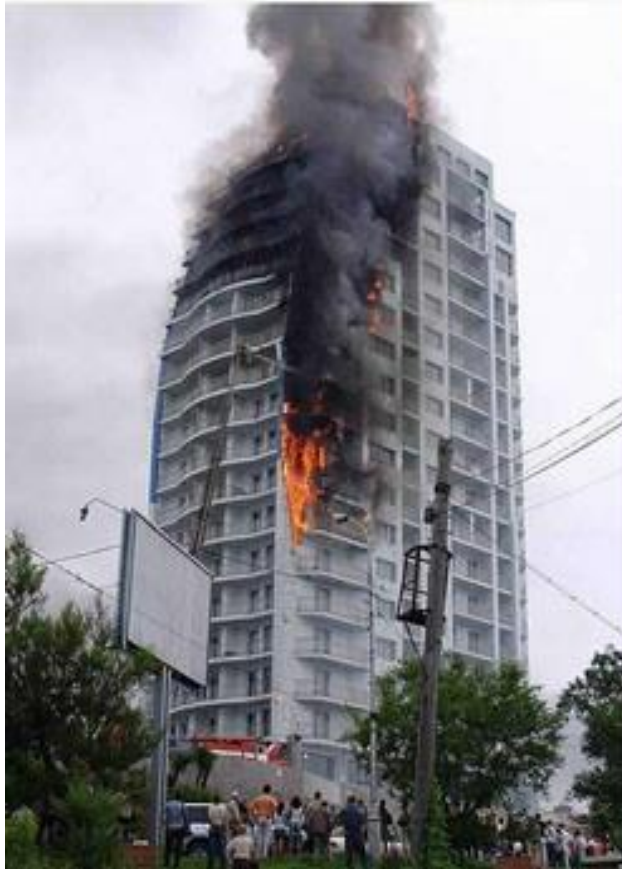
Пожар во Владивостоке - горит пенополистирол наружного утепления.
