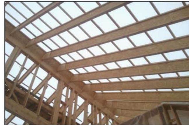
Монтаж крыши из двутавровых деревянных балок 45 см
