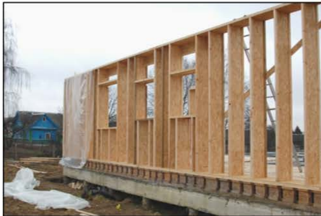
Монтаж стены из двутавровых деревянных балок 40 см
