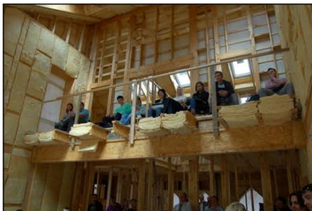
Внутренний вид в процессе строительства
