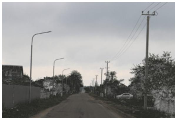
нико-экономическими показателями: ВЛИ-0,4 кВ — 0,451 км, ВЛП-10 кВ — 1,336 км, КЛ-0,4 кВ — 5,448 км, КЛ-10 кВ — 0,562 км, КЛНО — 1,259 км, 7 СТП 10/0,4 кВ, 16 распределительных щитов, оснащенных приборами учета для 61 бытового потребителя.
