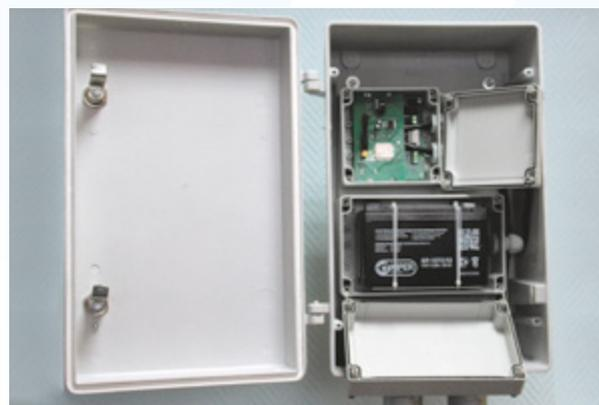
от коррозии используется избыточное количество станций катодной защиты (СКЗ) с не всегда оптимальными настройками режимов работы. Повышенный ток электрокатодной защиты приводит к нерациональному расходованию электроэнергии и увеличению интенсивности отказов оборудования СКЗ, пониженный ток электрокатодной защиты не обеспечивает требуемой защиты и приводит к коррозии металла трубопровода.
