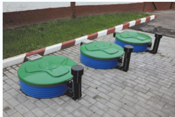
Очищенная вода пригодна для повторного использования в аппаратах высокого давления, что позволяет экономить до 90 % воды и снижает расход моющих средств. При полном опорожнении системы стоки отводятся в блочно-модульную установку очистки сточных вод «Кристалл-Р» производительностью 5 л/сек, где происходит трехступенчатая очистка стоков с последующим сбросом в сеть дождевой канализации.
