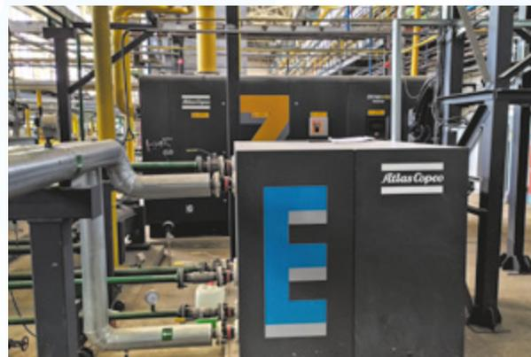
— Применение частотного привода позволяет обеспечить плавный пуск двигателя и избежать перегрузок сети предприятия в момент пуска компрессора.
