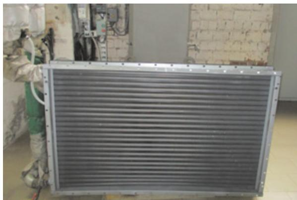
Реализация данного проекта позволила повысить эффективность сжигания природного газа на теплоисточнике за счет более глубокого охлаждения дымовых газов в конденсационных утилизаторах.
