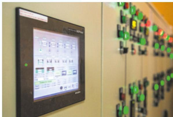
Система непрерывно рассчитывает и сравнивает показатели эффективности работы насосных станций: КПД и коэффициент удельных затрат.
